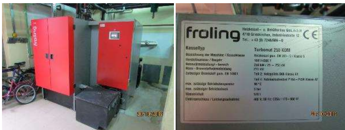
Slika 6: Peč na lesne sekance z visokim izkoristkom v OŠ Grad
