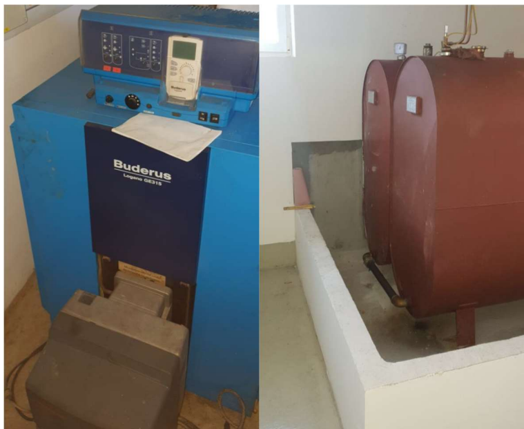
Slika 24: Obstoječa peč in rezervoar za kurilno olje v občinski stavbi
